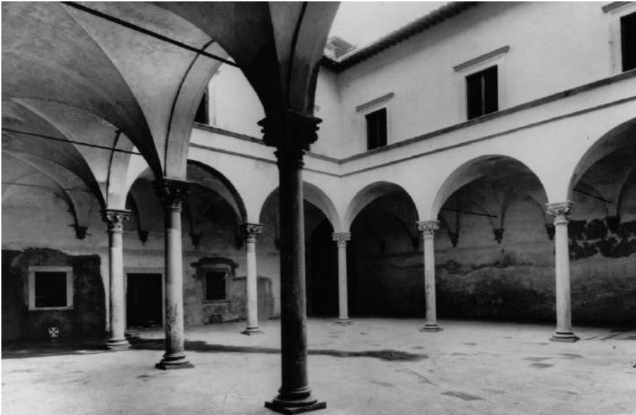
Fig. 2. Il cortile durante i lavori di ristrutturazione.
